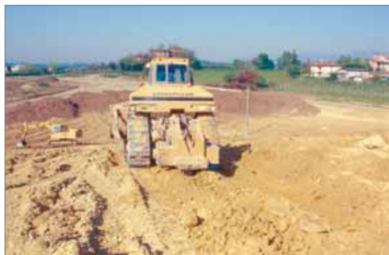
Fig. 5.13 - Operazione di rippatura profonda ( 100-120 cm); sarà seguita poi da una aratura superficiale (30- 40 cm).
