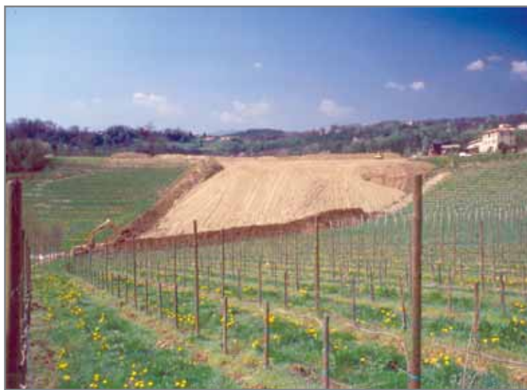
Fig. 5.6 - Nelle sistemazioni che prevedono importanti movimenti terra è buona norma operare con lo sterro del terreno superficiale (primi 40 cm).
