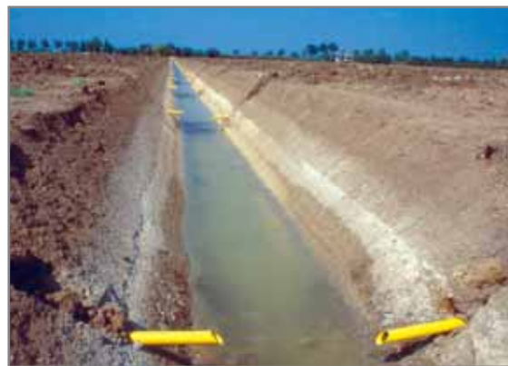
Fig. 5.21 - Canale di scolo nel quale confluiscono i tubi di drenaggio.
