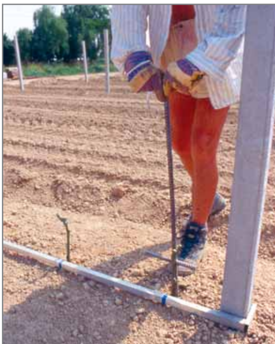
Fig. 5.38 - L'impianto con la forchetta deve essere eseguito con terreno ben preparato ed in tempera.
