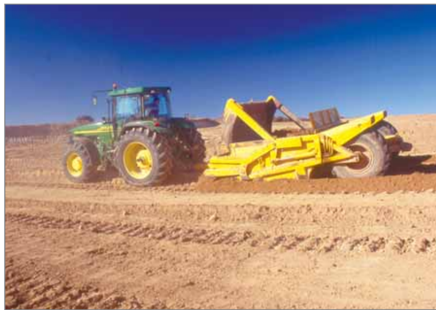
Fig. 5.19 - Trasporto di terreno nella fase di livellamento: può essere effettuato con pale meccaniche o livelli munite di laser, con barelle e autocarri per trasporto a distanze e levate.
