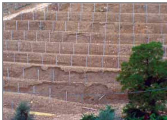
Fig. 5.26 - Franosità evidente in un cignionamento posto in forte pendenza con scarpate troppo ripide (più del 150%) e tipologia di terreno a tessitura sciolta poco coerente.
