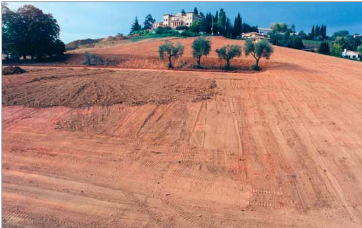
Fig. 5.7 - Si nota il riporto del terreno superficiale precedentemente accantonato.
