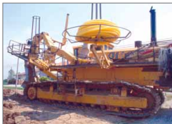
Fig. 5.20 - Macchina posadreni in fase di lavoro.
