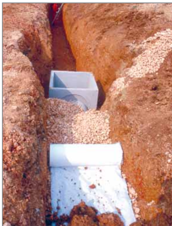
Fig. 5.9 - Drenaggio in fase di realizzazione. Gli scavi a sezione ristretta e con profondi variabile vengono riempiti con ghiaione meglio se rivestito da geotessile.
