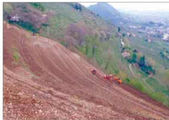
Fig. 5.14 - Le sistemazioni a gradoni o a cigliani raccordati permettono di meccanizzare parzialmente impianti in collina anche con pendenze superiori al 50%.
