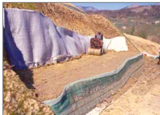
Fig. 5.18 - In determinate condizioni si può ricorrere all'utilizzo della tecnica delle terre rinforzate che prevede l'utilizzo di griglie elettrosaldate sagomate e geotessile come ritentore del terreno per favorire l'inerbimento.
